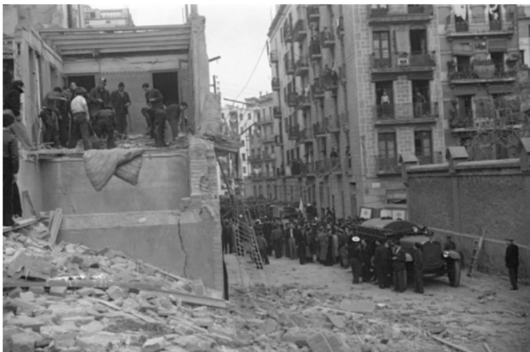
Destrosses a un habitatge de Barcelona en un bombardeig el març de 1937, amb alguns bombers en el desenrunament / Pérez de Rozas / Arxiu Fotogràfic de Barcelona
