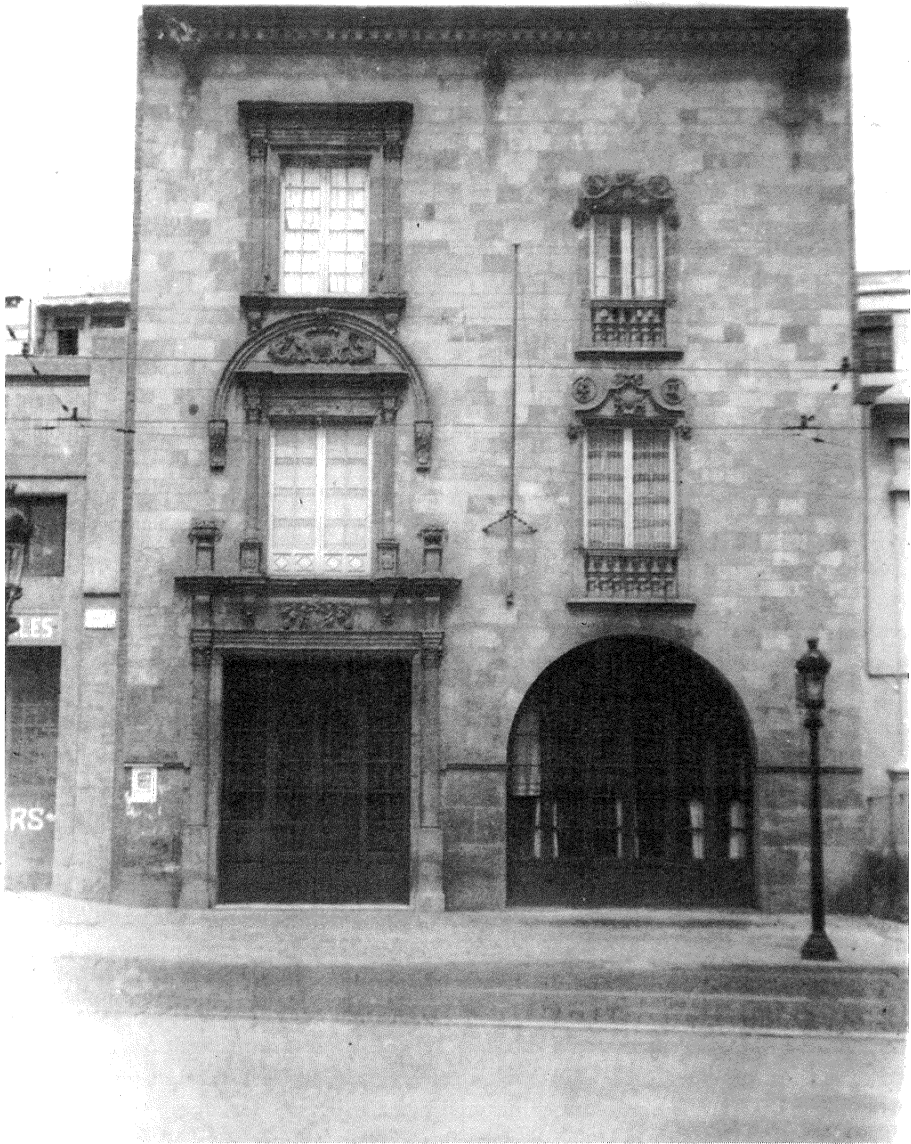
Edifici de la plaça de Lesseps, 1, avui l'edifici de l'Agència de Salut Pública, on es va instal·lar una petita caserna de bombers durant la guerra. (Foto: AMDG-FONS JB-CEG)
