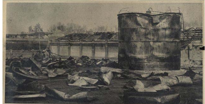
Aspecte de la CAMPSA després d'un dels bombardeigs
